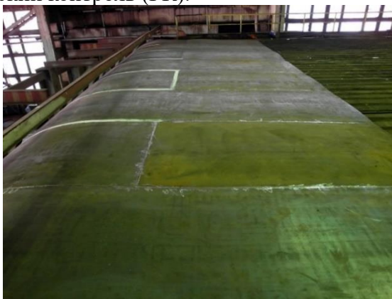
Рисунок 2. Сварка металла для скручивания в рулон
