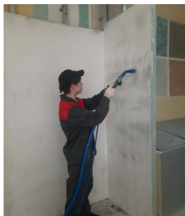
Рис. 4 Шпатлевание штукатурно-малярной установкой
