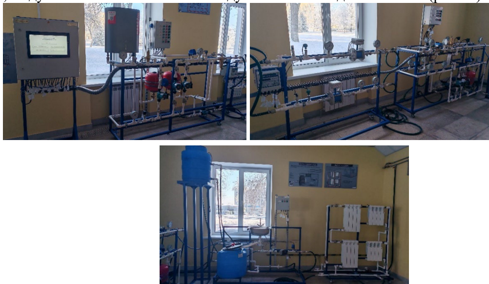
Рисунок 1. Учебная лаборатория системы теплоснабжения
