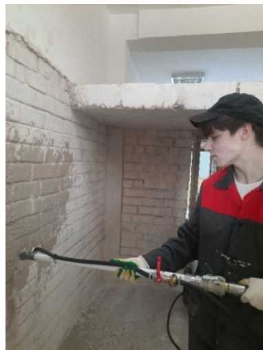
Рис. 2 Оштукатуривание штукатурной станцией
