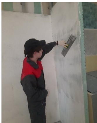
Рис. 3 Шпатлевание вручную
