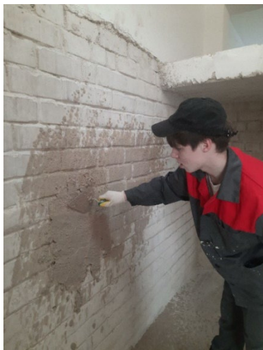
Рис. 1 Оштукатуривание вручную
